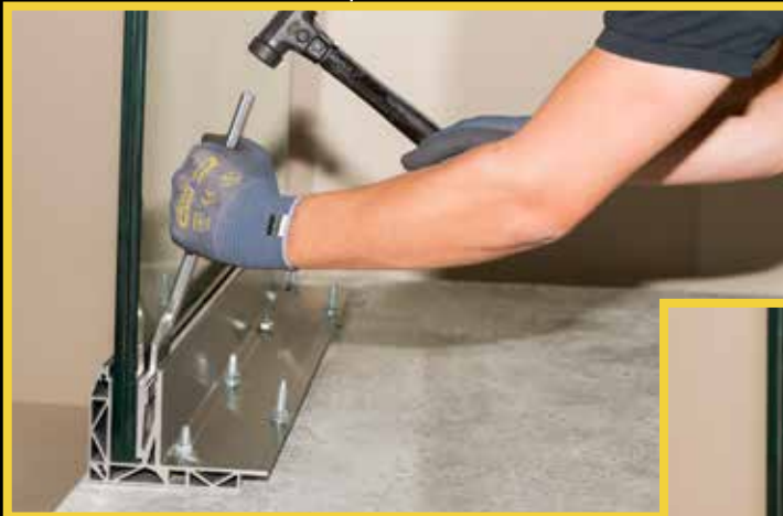
Aanslaan van de klemstrip
